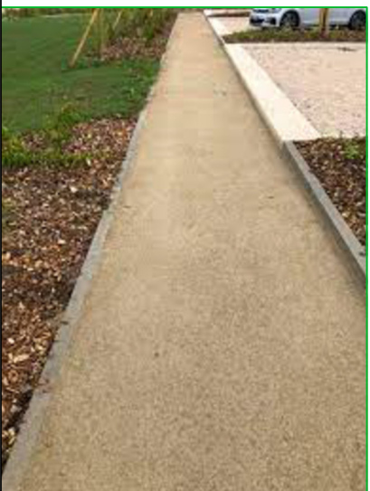
Visual des revêtements sur les trottoirs en périphérie du bourg, sur la route de Moustey, la route de Manio et la route de Sore. Trottoirs en stabilisé calcaire de type Saint Martin d'Ony.
