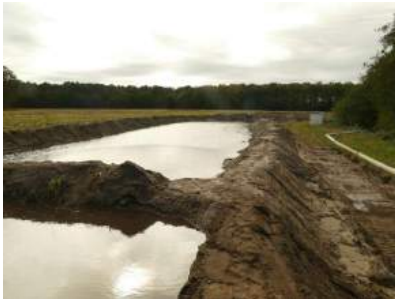
Bassin dessableur du Moulin – lagunage sédiment vaseux
