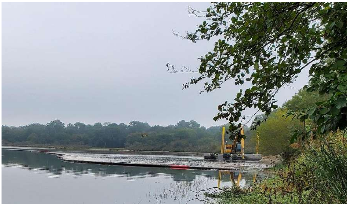
Travaux de curage du Petit étang de Biscarrosse à Biscarrosse
