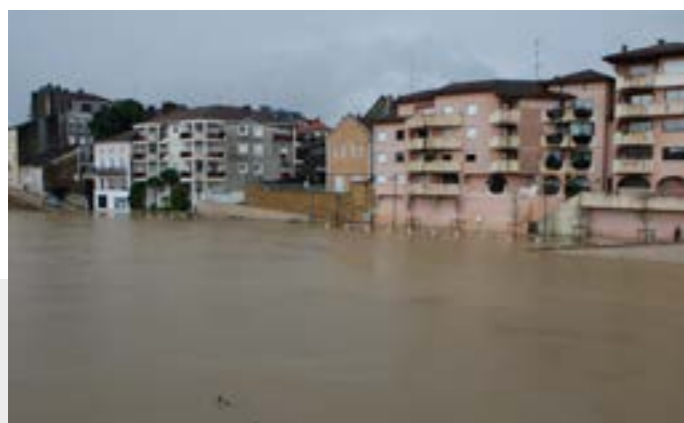
Inondation à Mont-de-Marsan en 2014
