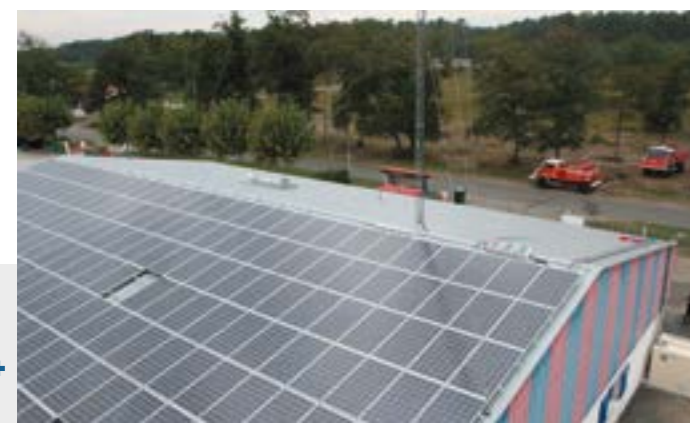
Toiture photovoltaïque du Centre de secours de Saint-Vincent-de-Tyrosse
