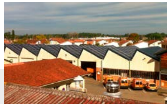
Toiture photovoltaïque sur un bâtiment départemental
