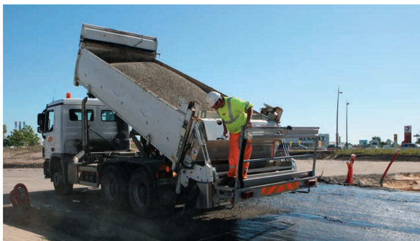
Imperméabilisation de la couche de forme © S. Zambon / CG40
