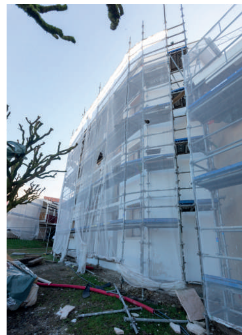
Chantier de réhabilitation et rénovation thermique à Dax
