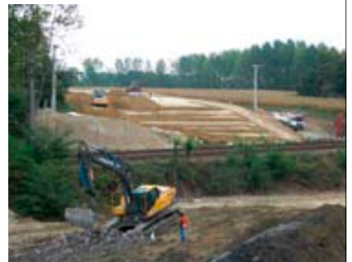
Travaux de terrassement sur l'opération de contournement Est de l'agglomération dacquoise
