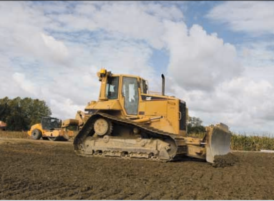
La pose de la première pierre du contournement Est de Dax est imminente.
