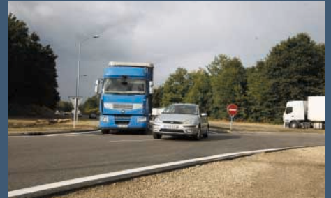
L'accès sur les giratoires de la route du Houga et de la route de Grenade se fait désormais sur deux voies.
