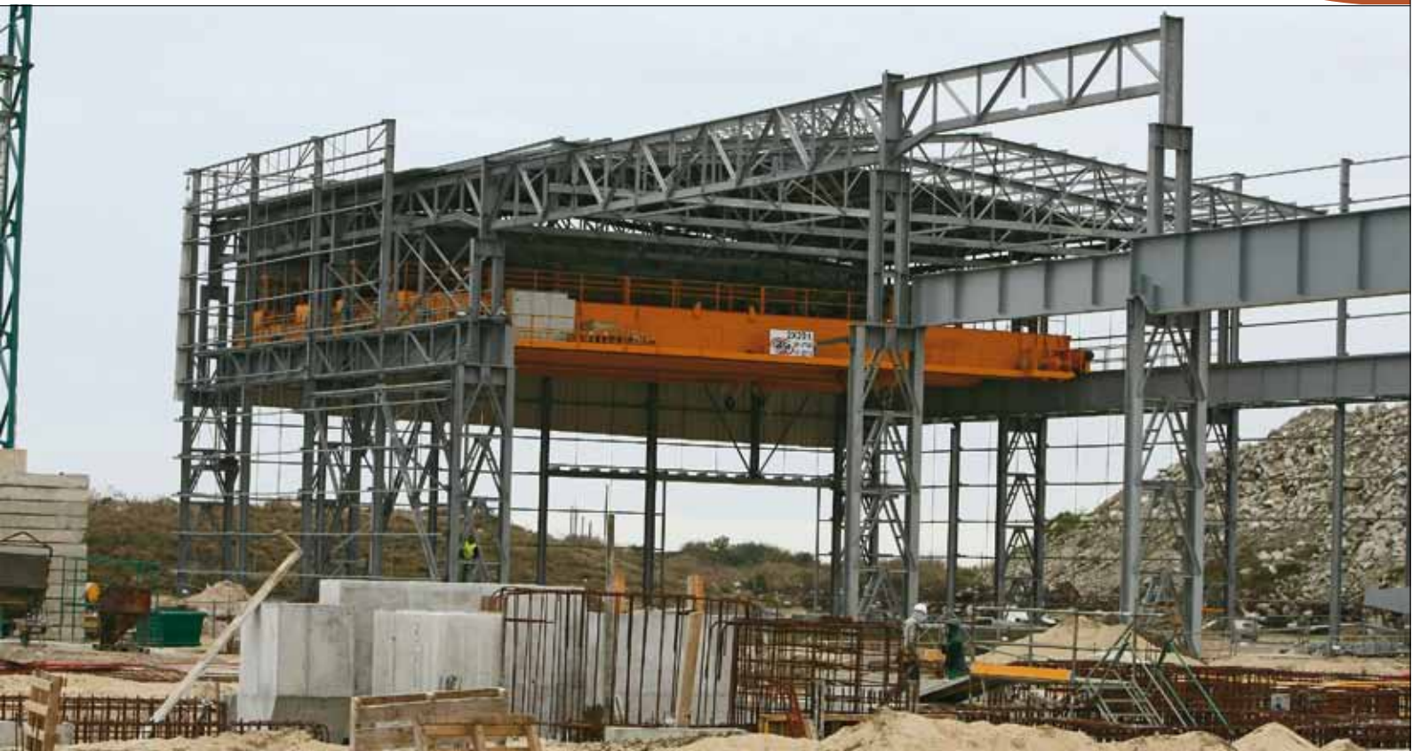
Le chantier du laminoir sur la zone portuaire de Tarnos.
